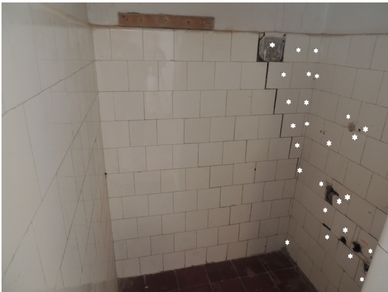
dlaždice označené hvězdou jsou určeny k výměně
